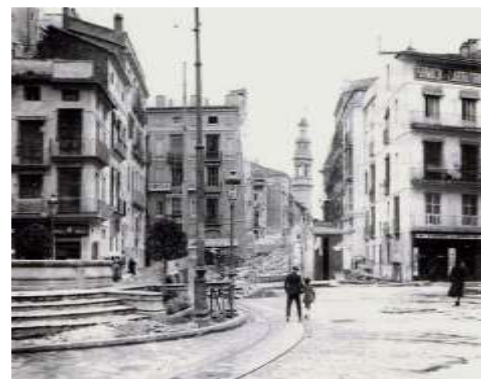
Derribos para ensanche de c/Navellos
